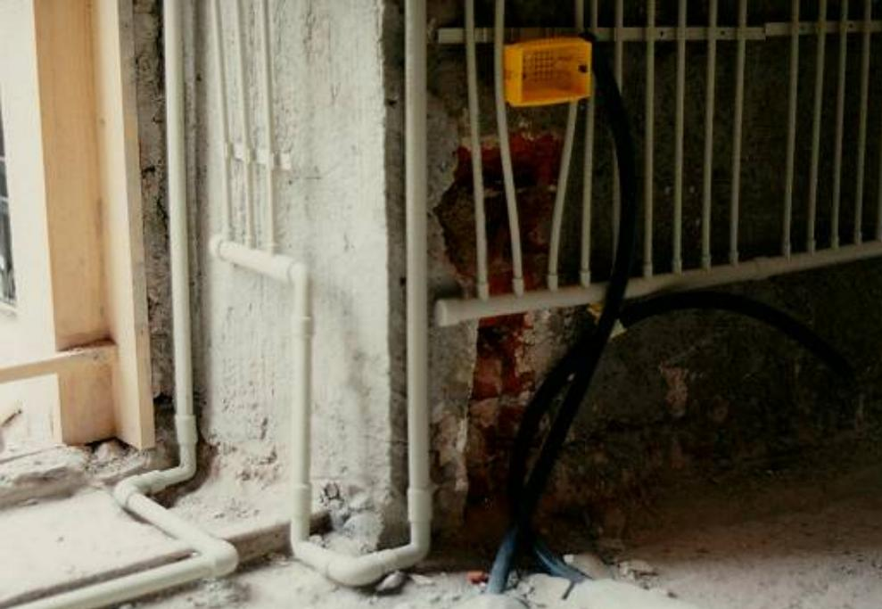
Integrazione con impianto elettrico che va realizzato prima di applicare i pannelli isolanti o le tubazioni.
