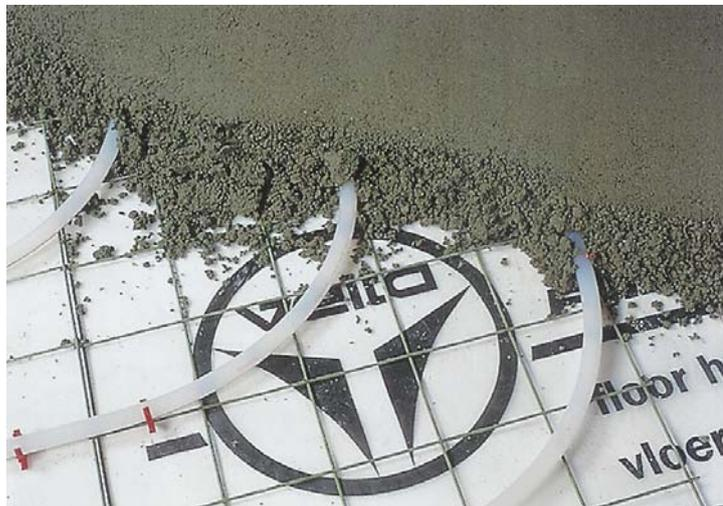
Figura 8 – Strato di supporto additivato
