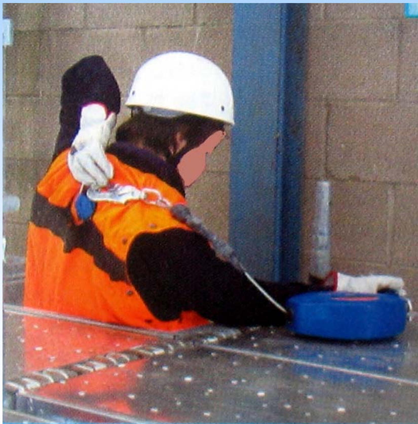
ASSICURARE L'ARROTOLATORE ALL'IMBRACATURA DI SICUREZZA
