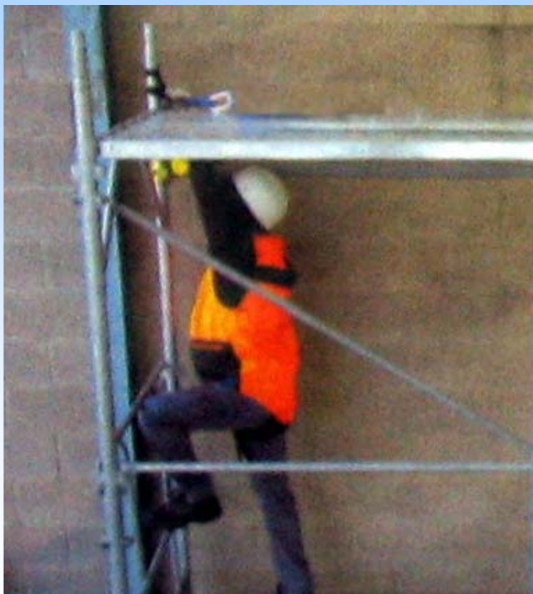
PREDISPORRE L'ANCORAGGIO AD UNA ESTREMITA' DEL PONTEGGIO
