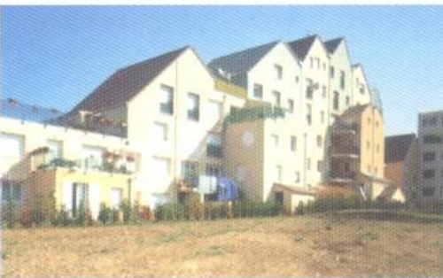
Demolizione parziale e rimodellamento di una stecca
