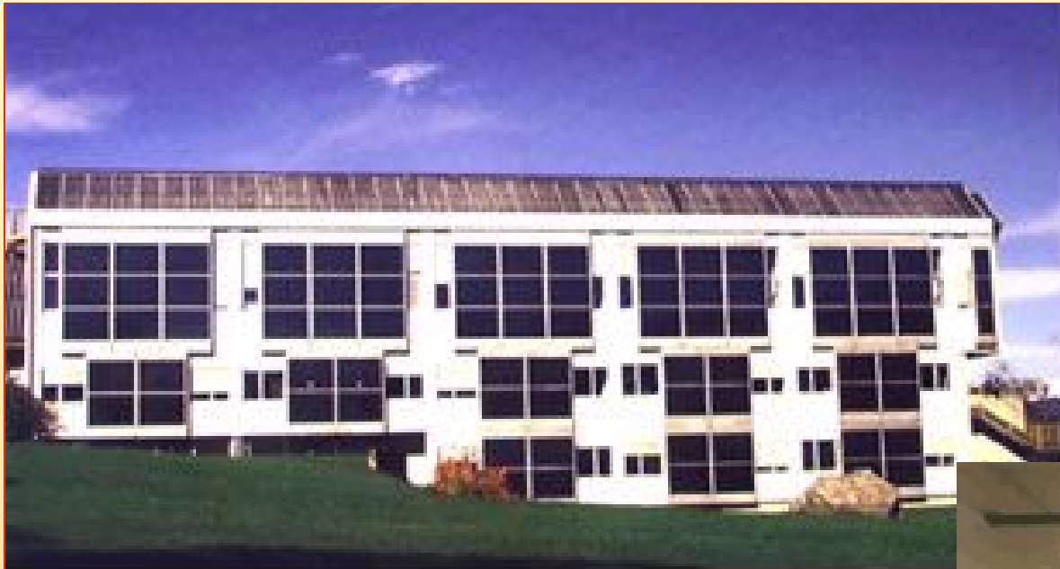
Componenti parete-camino solare integrati nella facciata sud del corpo B
