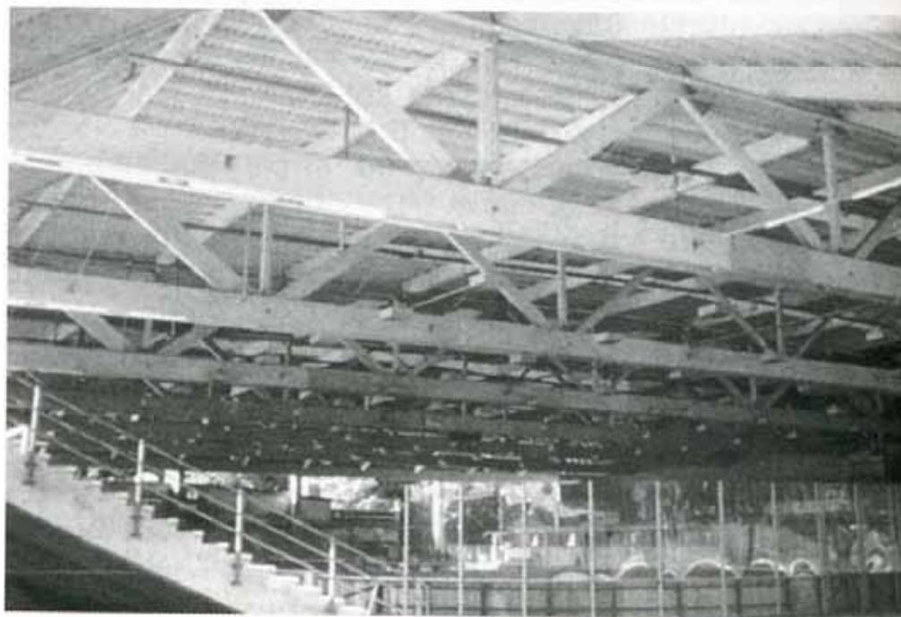
**Figura 4** *Tetto a struttura di legno di una piscina riscaldata.*
