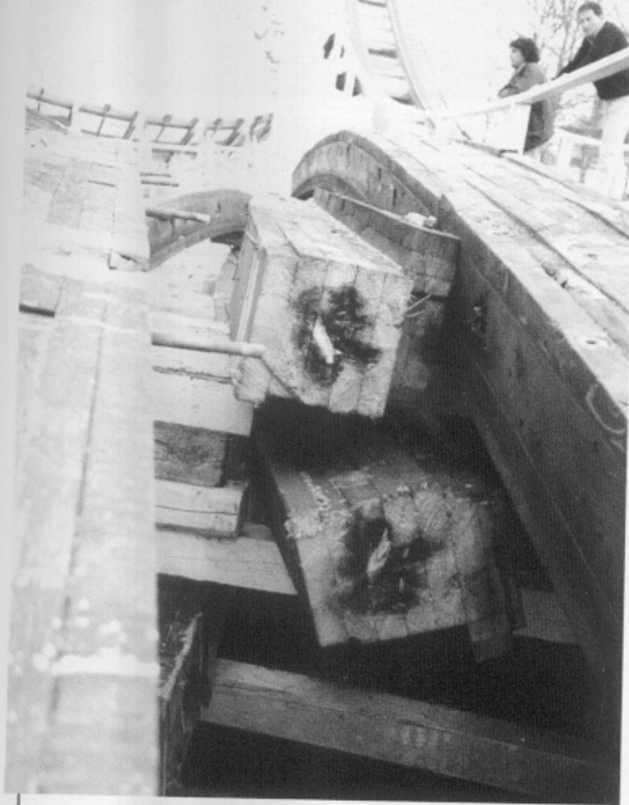
**2.45** Esempi di elementi portanti degradati dopo pochi anni dalla messa in opera: a) Riparazione del piede di montanti a diretto contatto con la strada; b) Attacchi di funghi della carie all'interno di elementi formati da pacchi di tavole inchiodate esposti alle intemperie
