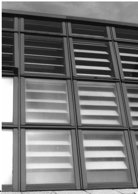
Sistemi Solari Passivi : Camino Solare
