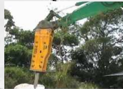
Escavatore : braccio con martello
