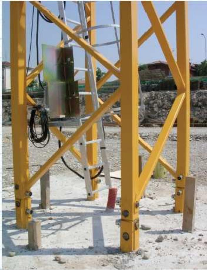
Gru a torre installata su basamento in cls tramite primo elemento a perdere
