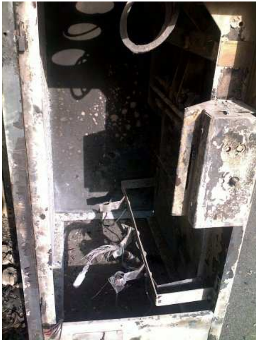
Figura 6.1: effetti di un incendio in cabina
