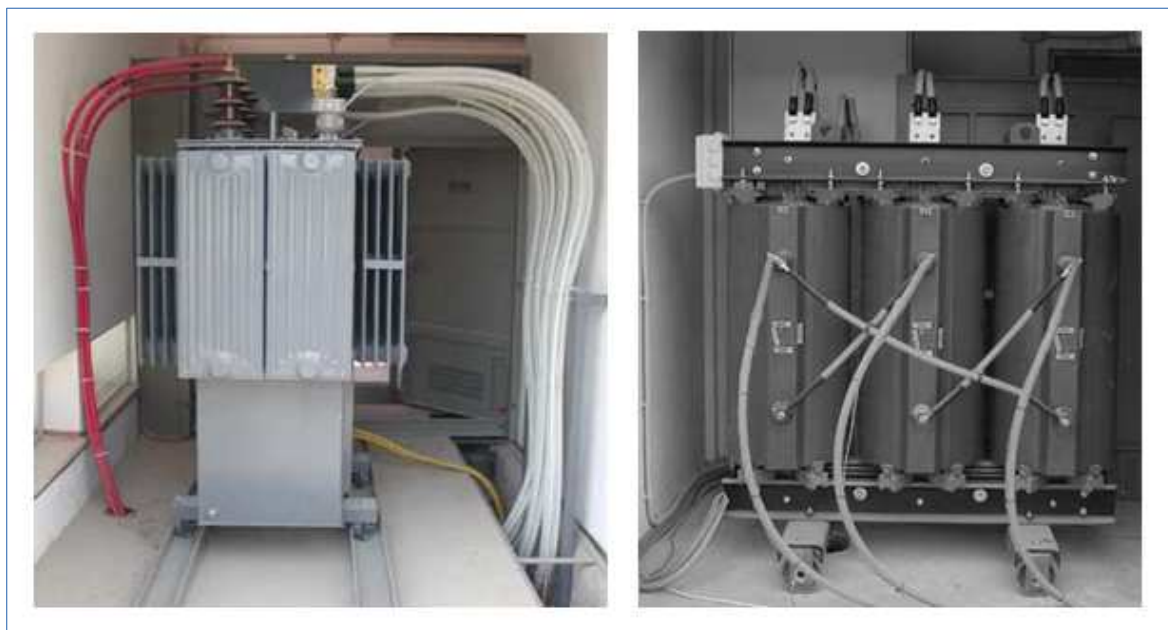
Figura 5.6: posa di conduttori in cavo
