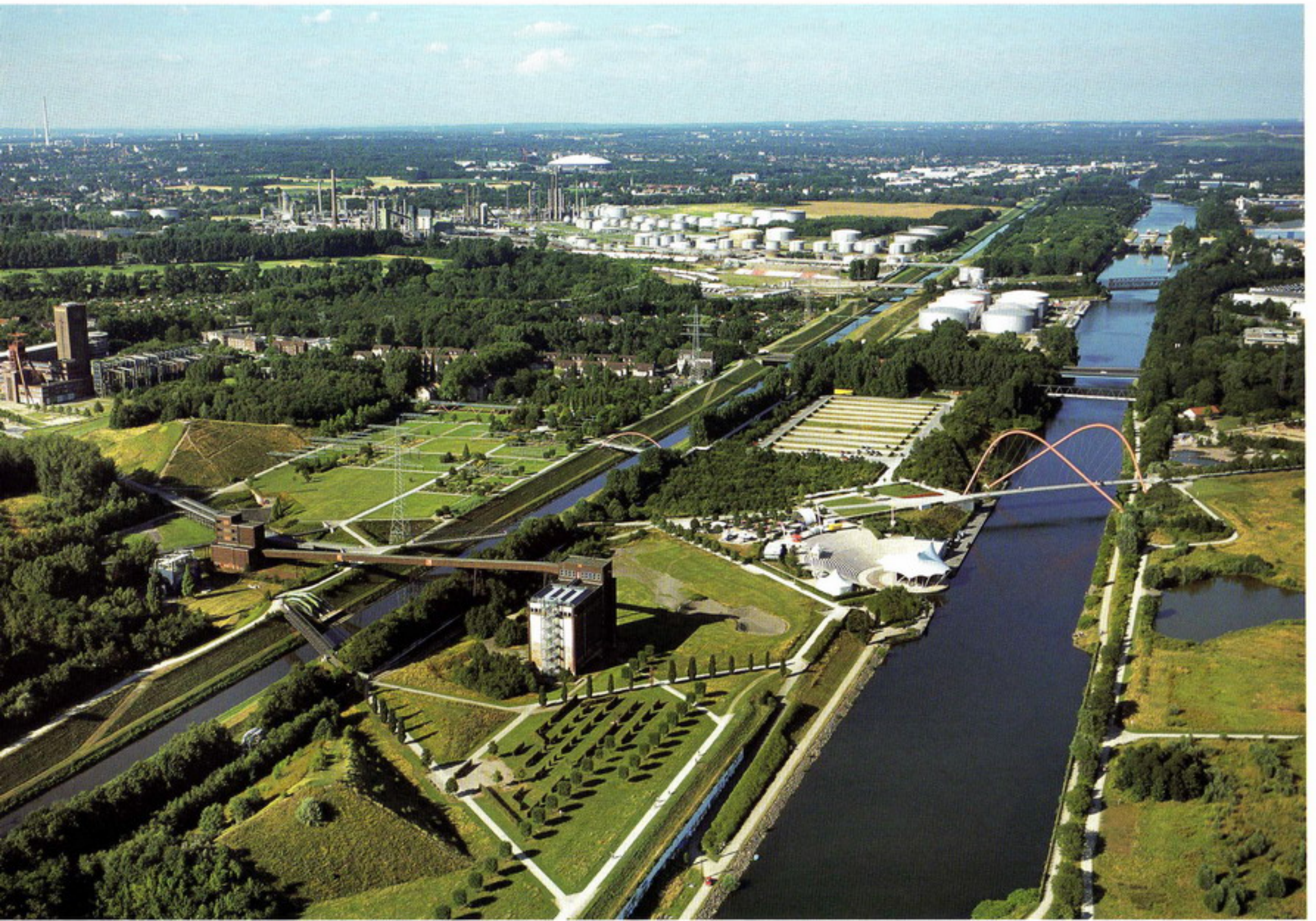
Brückenlandschaft Nordsternpark, Gelsenkirchen, 1997
