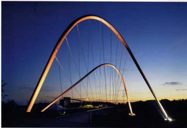
Doppelbogenbrücke über den Rhein-Herne-Kanal, Nordsternpark, Gefemäcker, 1997
