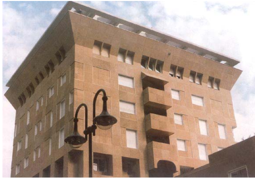
Facciata ventilata in Pietra Santa Fiora- Teatro di Giotto (PD)
